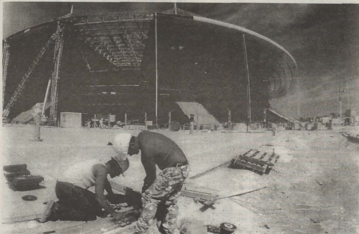
Lucrările de finisare sunt în plină desfășurare.
