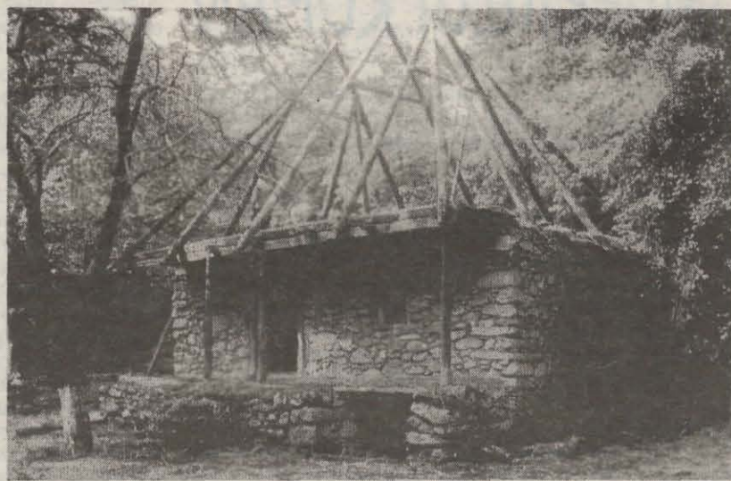
Casă cu pereți din piatră din Șerel, comuna Pui, județul Hunedoara (restaurată la Muzeul Satului din București).
